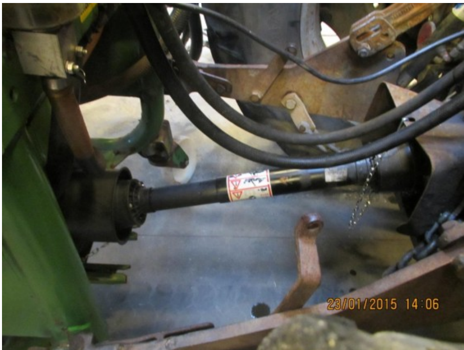
Billede 2. Kontrollerer at kraftoverføringsafskærmning og kæder er intakte. Foto: Hans Thostrup.
